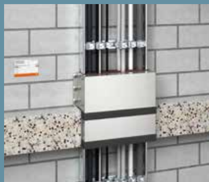
Variante comme calfeutrement de plafond via des voies montantes
