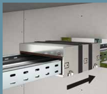
Insertion du boîtier dans l'ouverture murale
