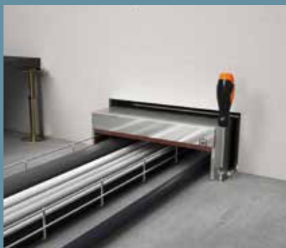
Insertion du boîtier dans l'ouverture murale et fixation au sol
