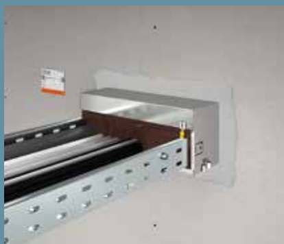
Raccordement de la liaison équipotentielle et pose de la plaque signalétique
