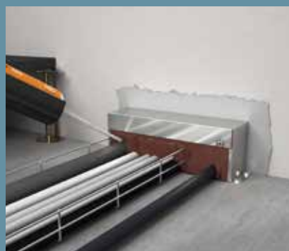
Obturation complète des petits espaces avec la mousse ignifuge PYROSIT® NG
