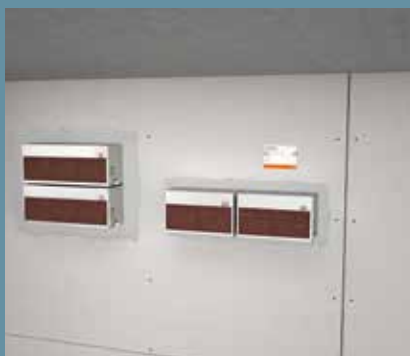
Formation de groupe de deux boîtiers possible de façon superposée ou adjacente
