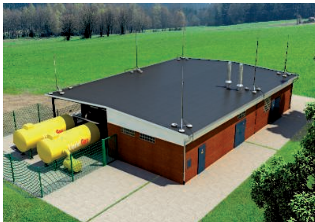
isCon®-afleiding op vangmast in Ex-omgeving
