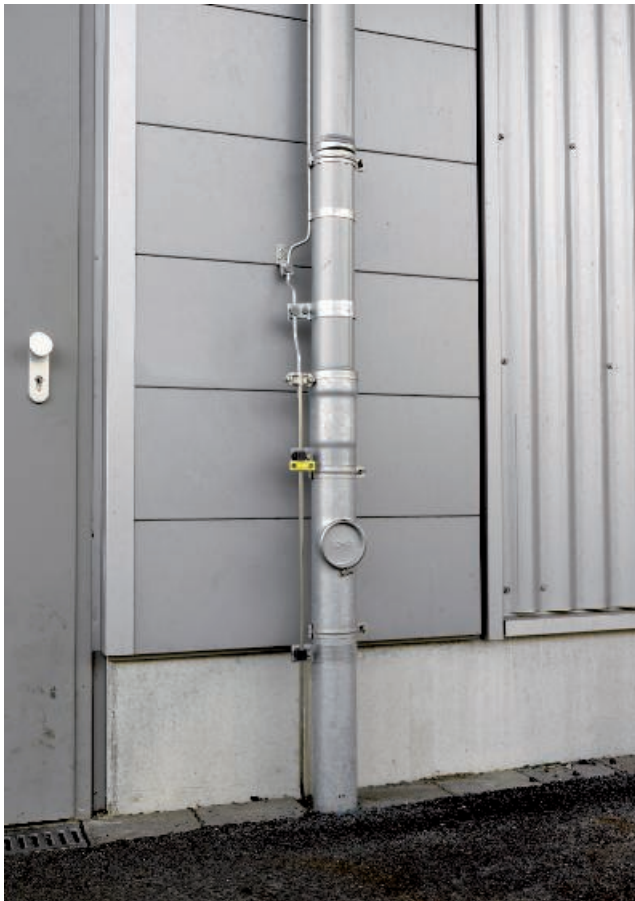
Bliksembeveiligingsafleiding op een regenpijp
