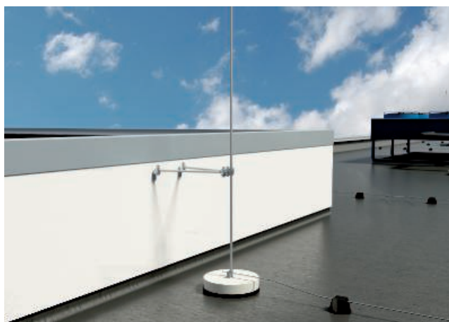
Gescheiden bliksembeveiliging met isolatiestutten
