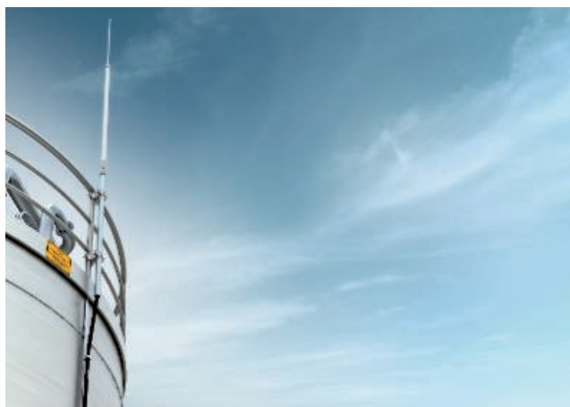
Gescheiden bliksembeveiliging met isCon®
