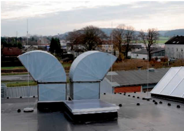
Gescheiden systeem met GFK-houders
