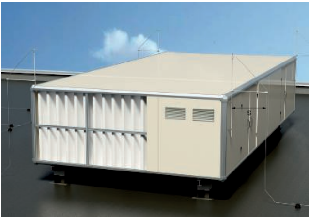
Geïsoleerde opvanginrichting met scheidingsafstand (s)
