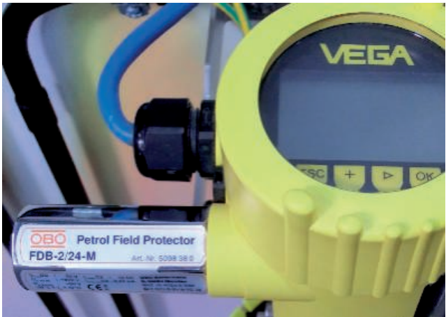
Sensor met Petrol Field Protector FDB
