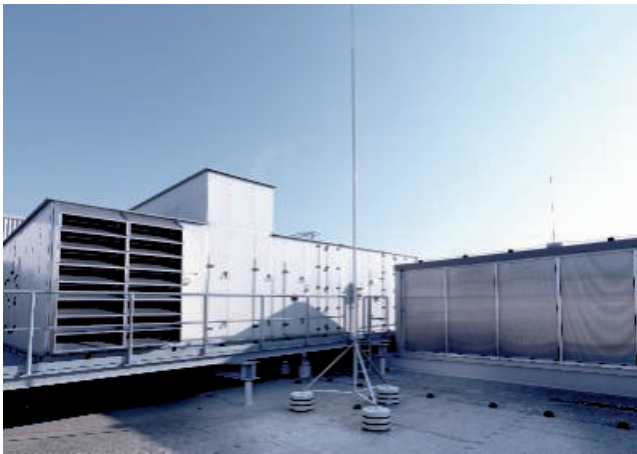
Geïsoleerde bliksembeveiliging met isFang
