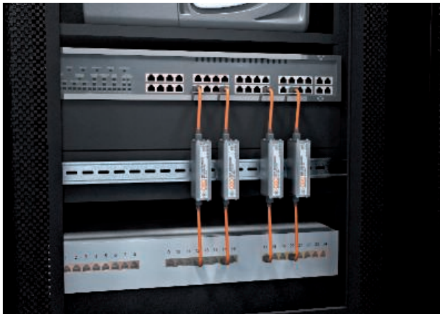
Beveiligingsvoorstel aan switch met patchveld De overspanningsbeveiligingen zijn via de DIN-rail geaard.
