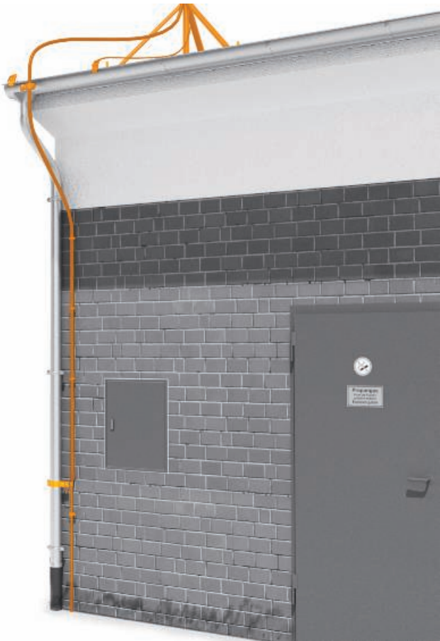
Voorbeeld: beveiliging van een gasstation met isCon®-afleiding
