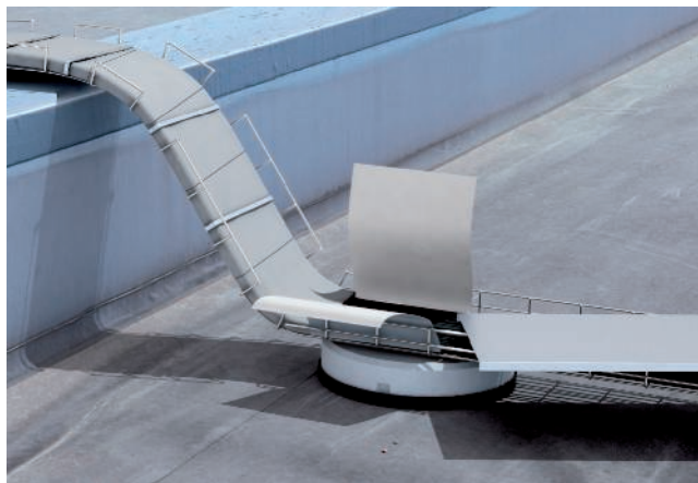
Over de brandwand geïnstalleerde leidingen met bandage
