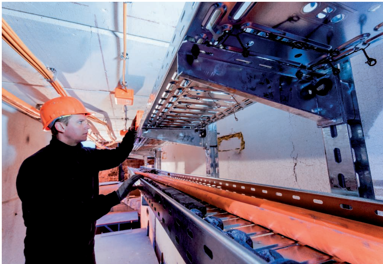
Testopstelling van een kabelinstallatie met functiebehoud
