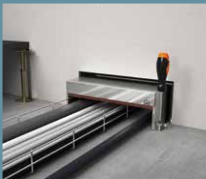
Plaatsen van de box in de muuropening en bevestiging in de vloer
