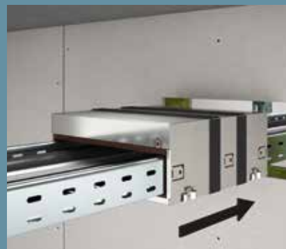
Box in de muuropening plaatsen
