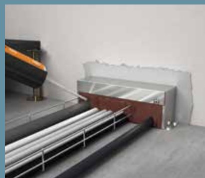
Tussenruimte geheel met PYROSIT® NG brandwerende schuim afsluiten
