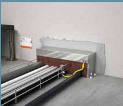
Potentiaalvereffening aansluiten en identificatieplaatje aanbrengen
