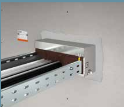
Potentiaalvereffening aansluiten en identificatieplaatje aanbrengen
