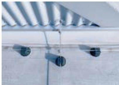
*Raccordement d'une façade métallique au système de protection contre la foudre*
