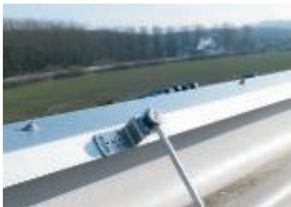
*Raccordement d'un acrotère métallique au système de protection contre la foudre*
