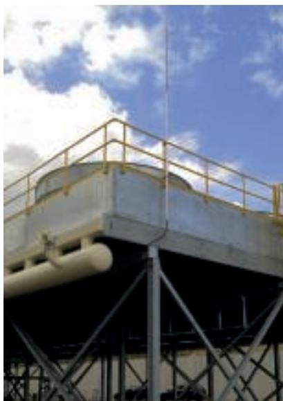
Conducteur de descente isolé dans une zone à risque d'explosion
