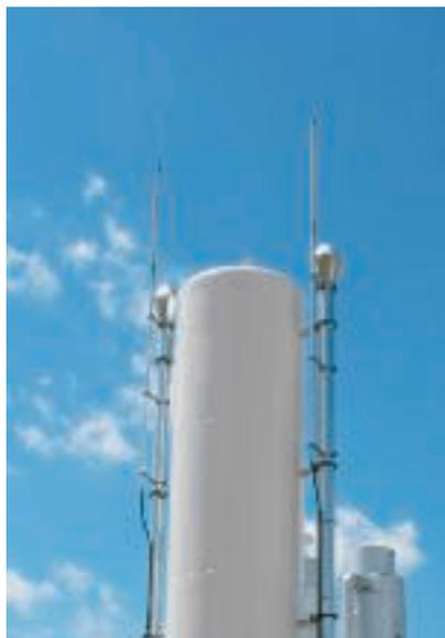
Conducteur isolé isCon® pour installation bio-gaz
